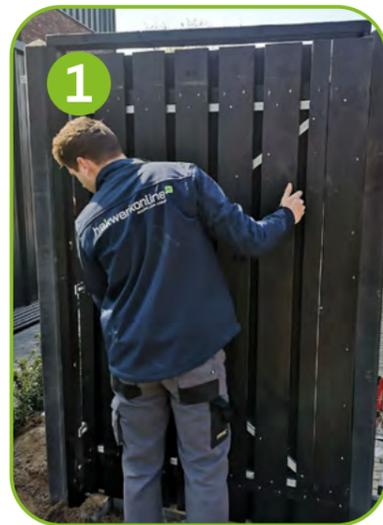
**1** Stellen Sie das Tor auf eine Erhöhung, z. B. ein 4 oder 5 cm hohes Stück Holz. Je nachdem, wie hoch das Tor über dem Boden sein soll. Überprüfen Sie, ob Ihre Markierungen der Daumenplatten noch richtig sind. Schrauben Sie die Daumenplatten an und achten Sie darauf, dass sie genau in der Mitte des Rahmens liegen.
