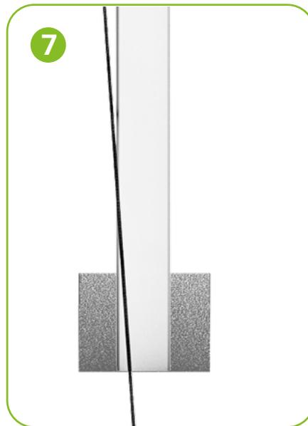
Setzen Sie den Pfosten in das Loch. Prüfen Sie mit einer **Wasserwaage**, ob er eben und fest am gespannten Draht anliegt. Schlagen Sie ihn dann in der richtigen Höhe in den Boden ein. Verwenden Sie dazu gegebenenfalls einen Pfostenstampfer. Der Multi-pfosten geht in der Regel **60 cm tief** in den Boden. Wir empfehlen, den Zaun mindestens 5 cm über dem Boden zu platzieren.
